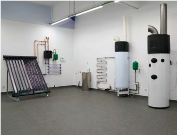
Sala Prática - Eletrificação A.Q.S.
